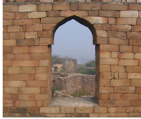
আলোকচিত্র-৬ : সুলতান ঘোরির সমাধিতে (১২৩১) ব্যবহৃত ক্রমপ্রলম্বন খিলান
